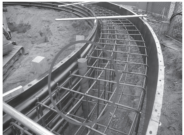
図-9 ガイドウォールコンクリート注入孔確保
