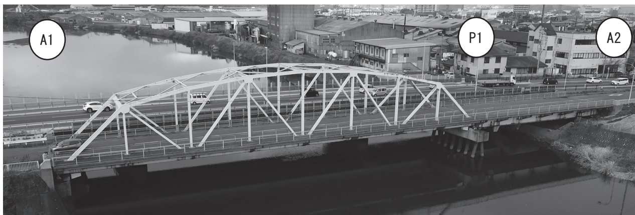
図-2 旧新川橋撤去前
