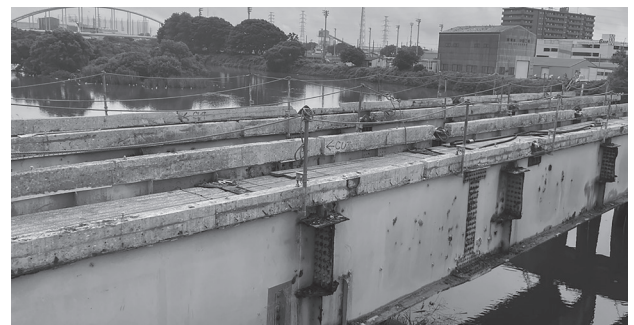
図-11 合成鉄桁床版撤去完了状況
