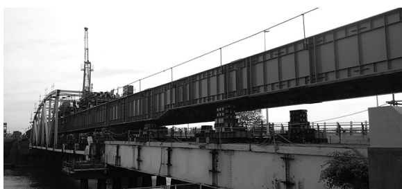
図-3 架設桁設置状況
