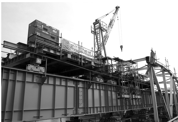
図-4 クレーン台車設置状況
