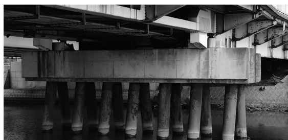
図-6 P1橋脚現況
