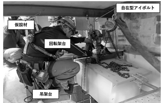
図-9 部材回転機構
