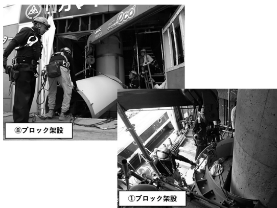
図-6 鋼板巻き立て架設状況
