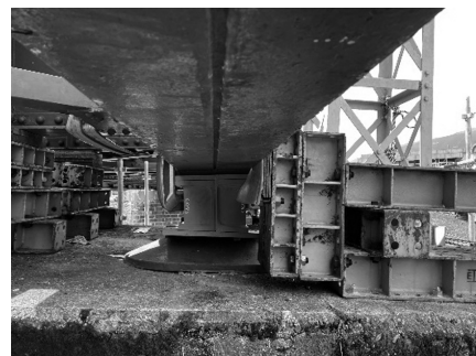
図-4 落橋防止設備設置状況
