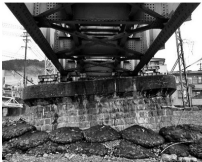
図-3 ねじれ整正状況
