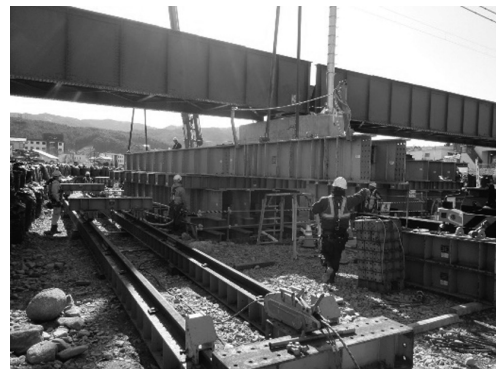
図-9 相吊り状況
