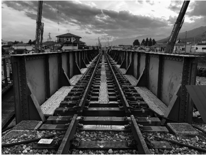
図-8 線路設備復旧
