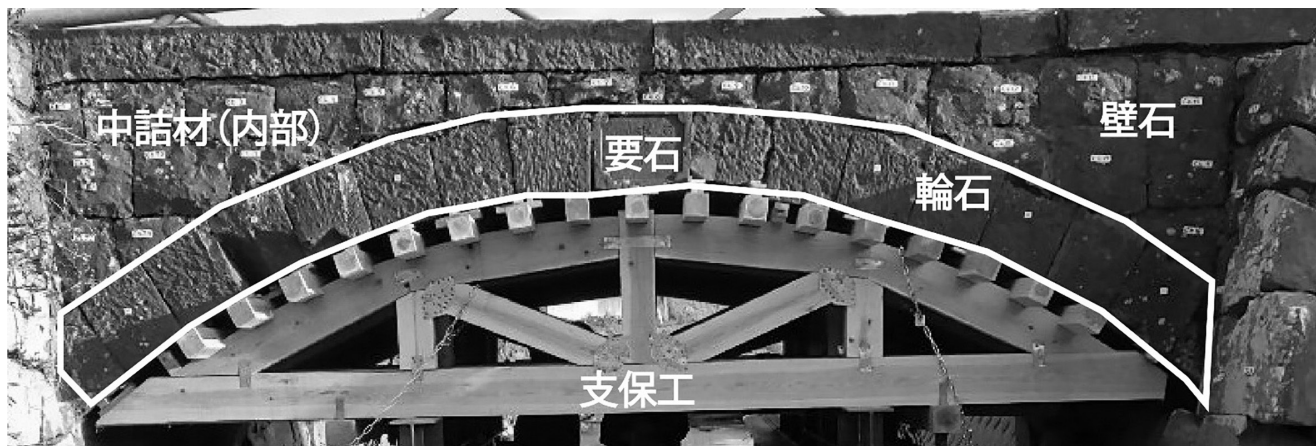
図-1 アーチ型石橋の各部の名称と基本構造
