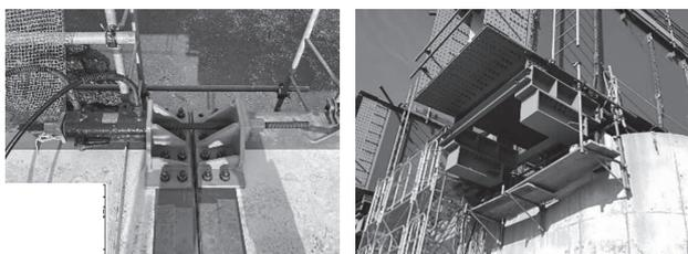
**図-9 引込装置(桁上) 図-10 仮固定装置**
