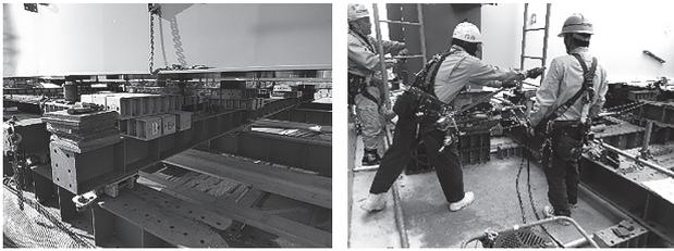
図-4 縦送り架台 図-5 縦送り状況
