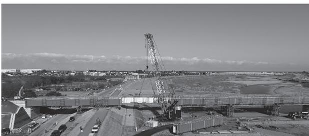
図-7 落とし込み架設状況
