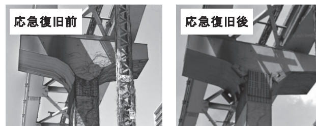
図-2 施工箇所周辺および応急復旧状況
