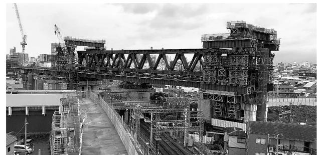
図-9 トラス縦送り完了
