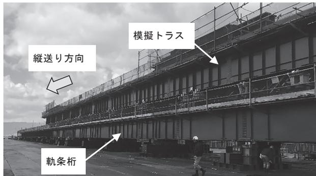
図-7 トラス縦送り実証実験
