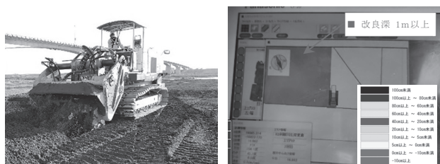
図-3 ICTスタビライザ施工管理モニタ
