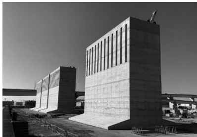
図-1 本体工（コンクリート工）完成時
