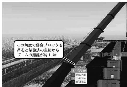
図-4 クレーンブーム接触確認
