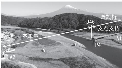
図-1 支点支持状態の既設桁（工事着手前）
