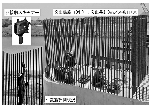
図-2 突出鉄筋と計測状況写真
