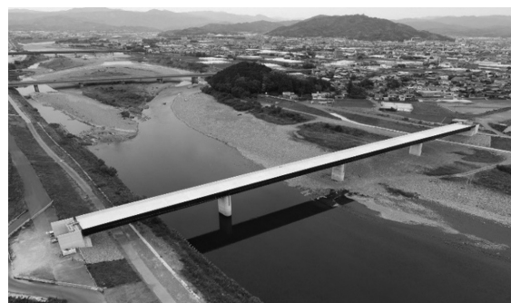
図-6 工事完成写真
