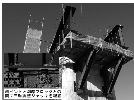
図-5 斜ベント設置状況
