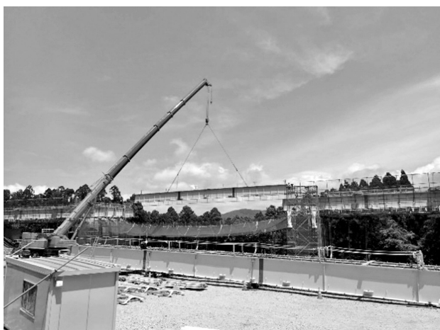
図-2 主桁架設作業状況
