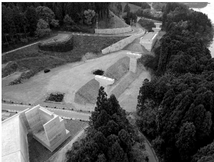
図-1 現場施工前
