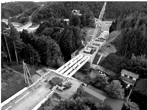
図-2 主桁架設作業完了
