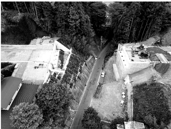
図-1 施工前状況 (相川2号橋)
