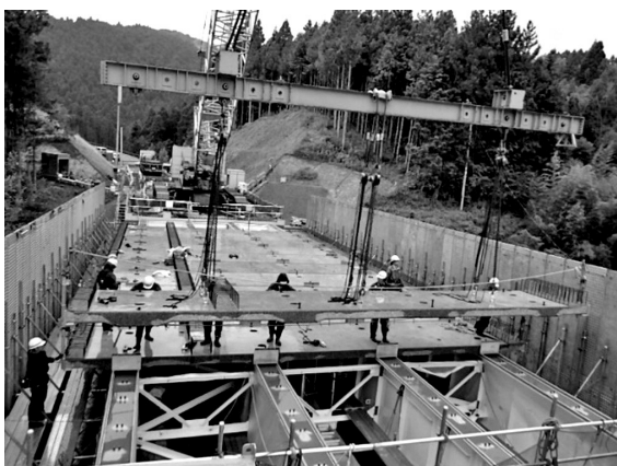
図-3 エルスジョイント施工状況
