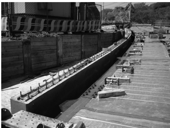
図-3 縦壁施工完了
