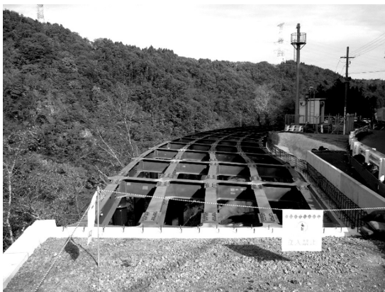
図-1 現場施工前状況
