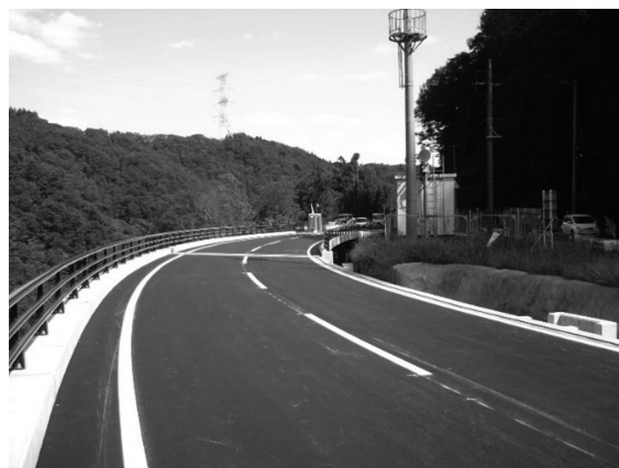
図-4 現場完成全景
