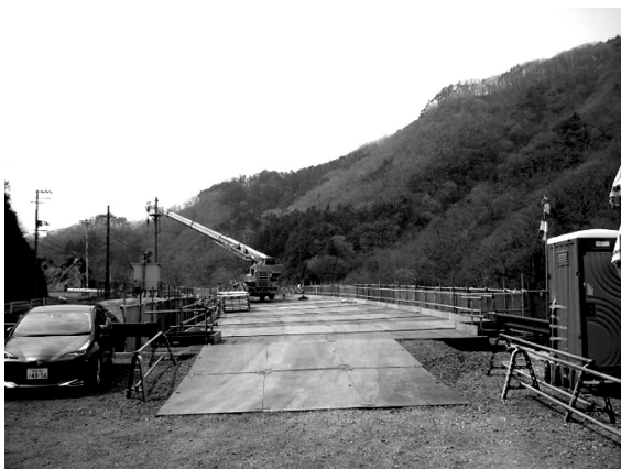
図-2 覆工板設置全景
