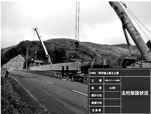
図-2 主桁架設作業状況 (200tクレーン相吊)
