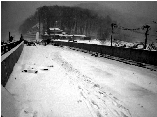
図-3 壁高欄完成
