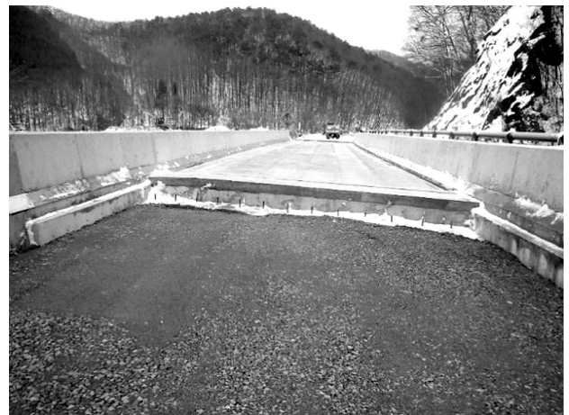
図-4 工事完成全景
