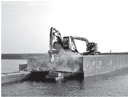
図-2 コンクリート取壊し状況
