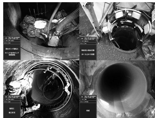
図-2 水替の工夫 (左上) リング型送風機 (右上) 製管状況 (左下) 完成 (右下)
