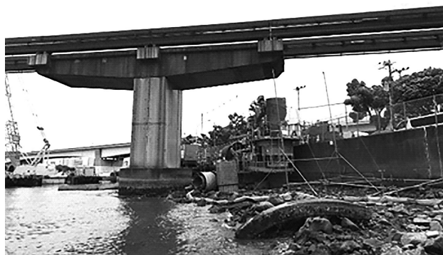
図-1 東京モノレール下での施工状況写真
