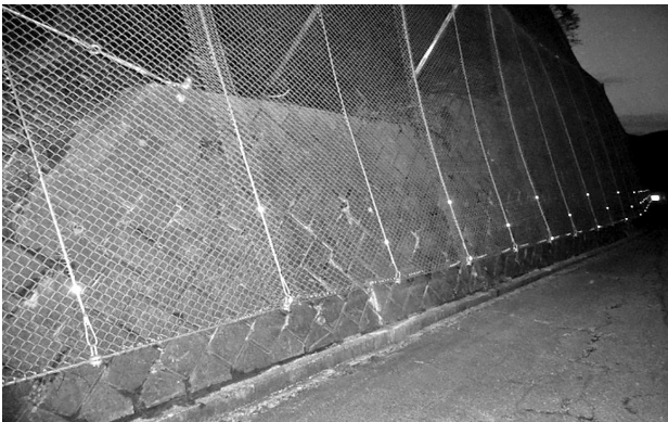
図-4 反射テープ取付け
