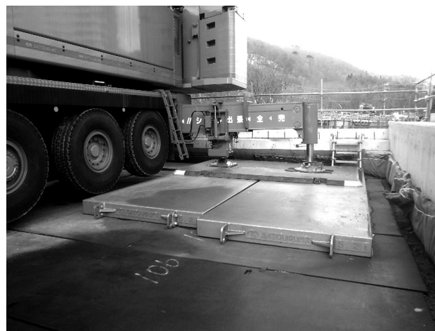
図-4 専用覆工板使用状況
