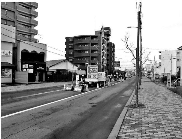
図-2 作業帯工事防護柵
