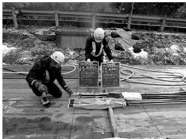
図-3 布製材料ロックボルトパッカー
