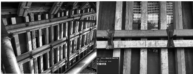
図-3 透明型枠設置
