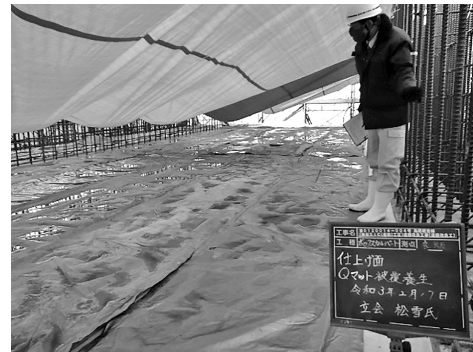
図-3 Qマット設置状況
