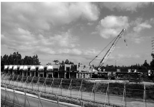
図-3 桁の仮置き
