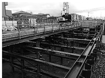
図-6 土留工全景
