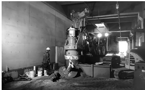
図-4 BG工法による支障物撤去状況
