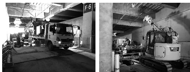
図-5 施工写真（掘削土砂積み込み）
