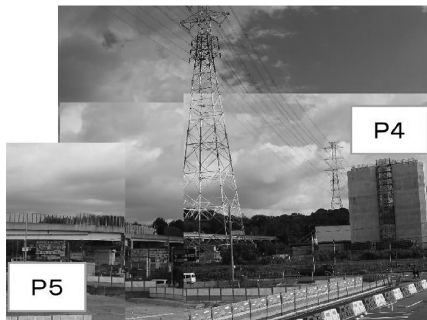
図-2 P4～P5間の現場状況 (施工前)
