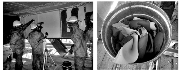
図-5 塗膜除去状況と剥離塗膜回収
