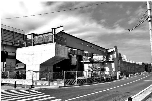
図-4 多賀橋迂回路橋架設完了状況
