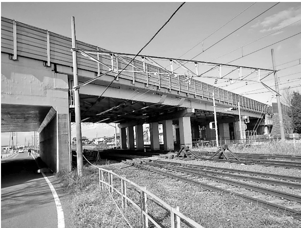
図-1 本線橋梁（多賀橋梁）
