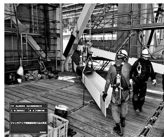
図-4 トラス部 部材吊り上げ状況
