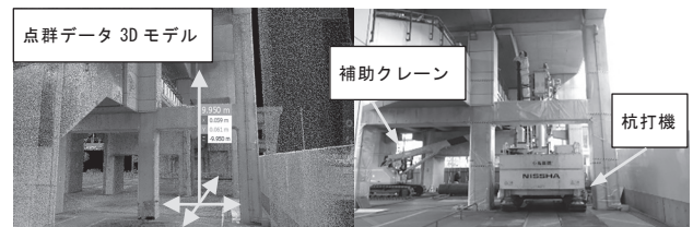
図-1 施工空間の把握 図-2 杭打機配置状況
