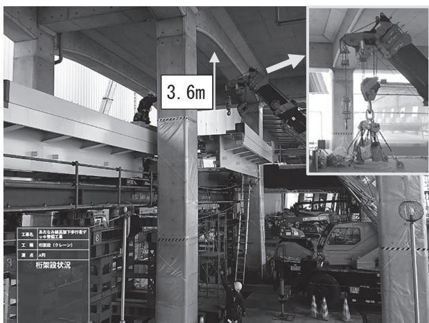
図-4 デッキ桁架設状況
