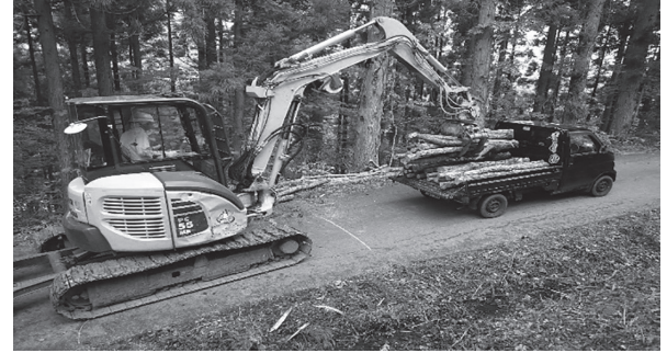
図-5 地元地権者引取り時の伐採木積込み
