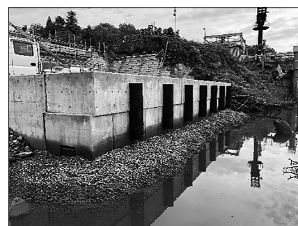
図-5 防舷材取付け完了時
