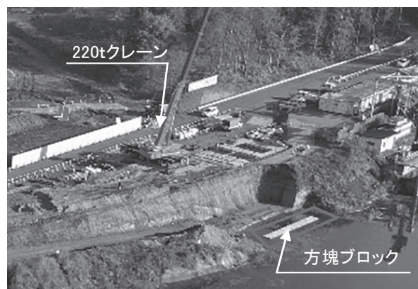
図-1 施工で使用した220tクレーン
