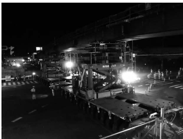
図-3 主桁架設時の状況
