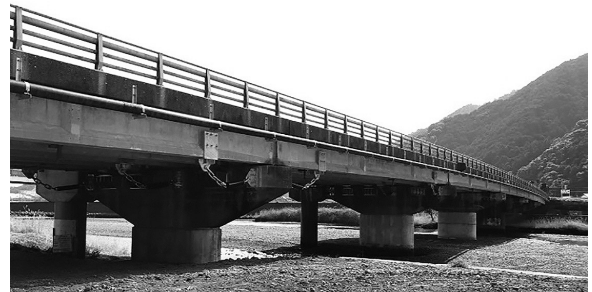
図-1 新莊川橋全景
