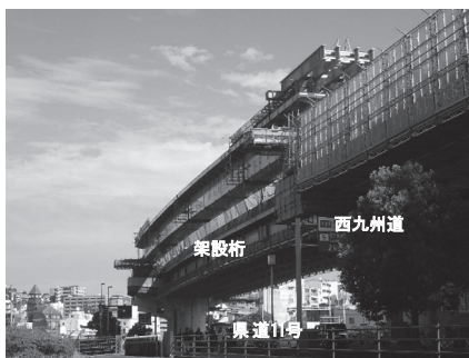
図-1 横取り架設完了状況
