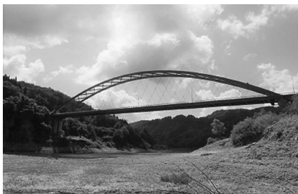
図-1 中津川橋全景（補修前）
