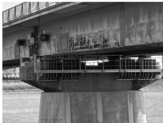
図-5 施工完了写真
