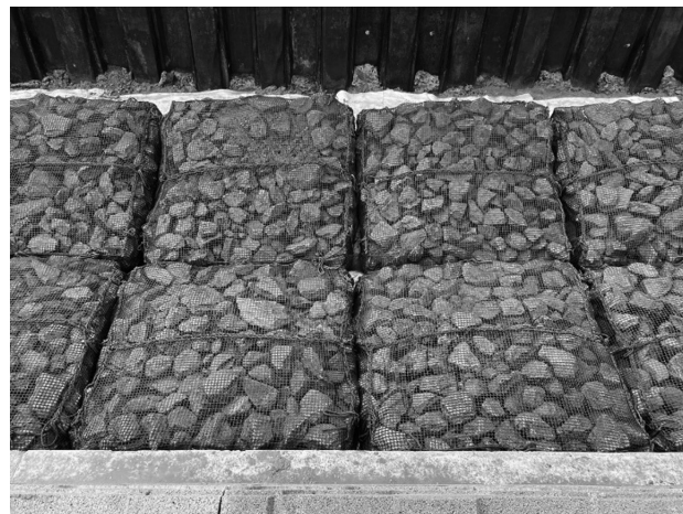
図-3 完成時袋詰玉石状況
