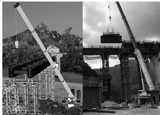
図-4 3次元モデルと実際の架設状況
