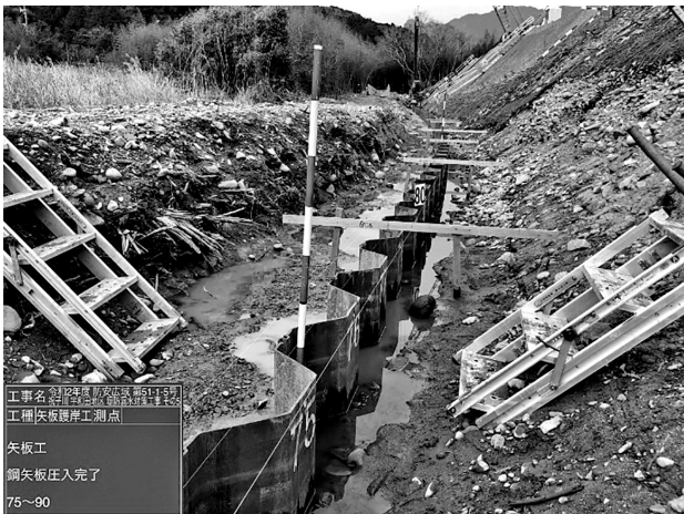
図-3 鋼矢板施工完了
