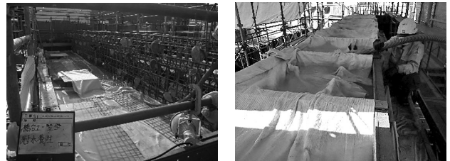
図-3 湛水養生状況
