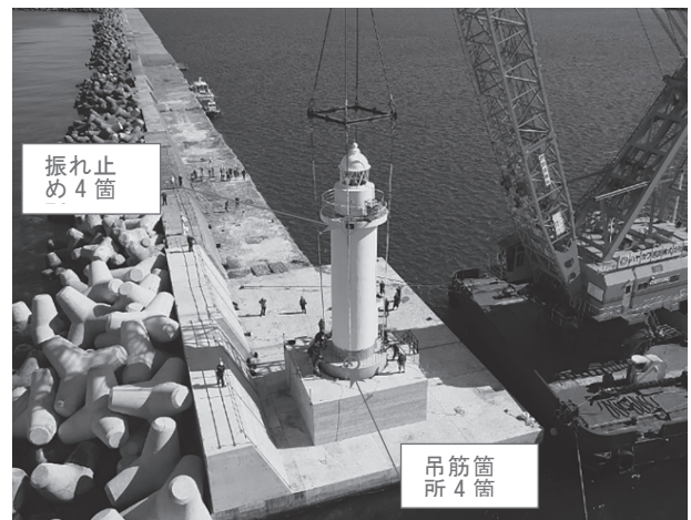
図-5 灯台設置状況
