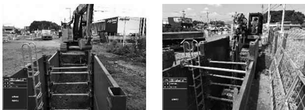
図-2 土留材設置
