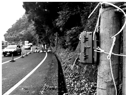
図-4 カメラ設置による夜間交通状況の観測
