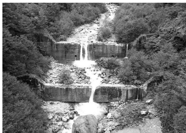
図-1 補修・補強対象の北股第1号砂防堰堤
