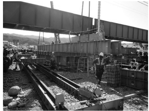
図-9 相吊り状況
