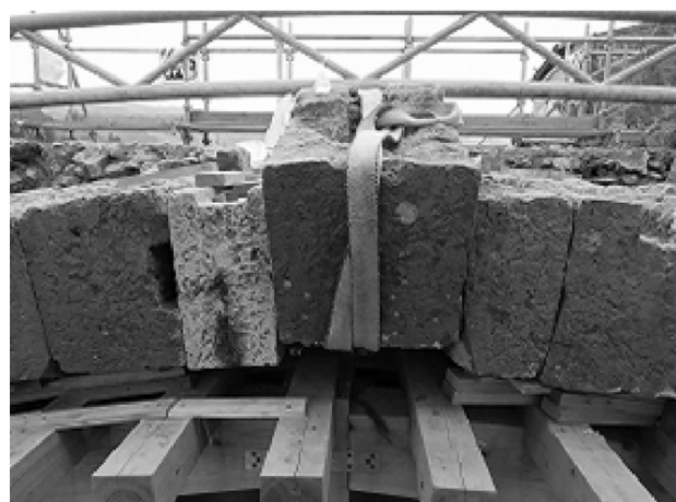
図-4 輪石組み2回目（下流側）
