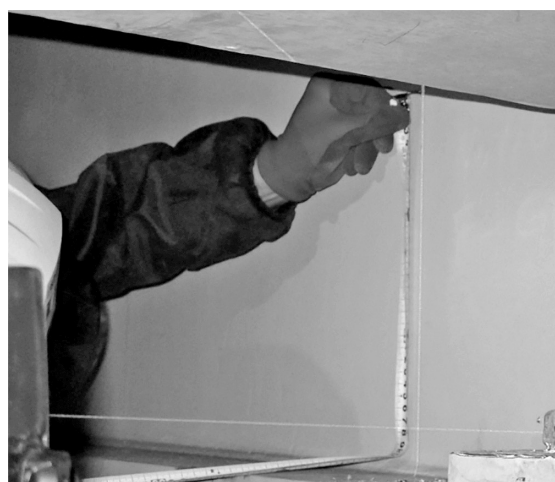
図-3 レーザー墨出し器を用いた計測の様子
