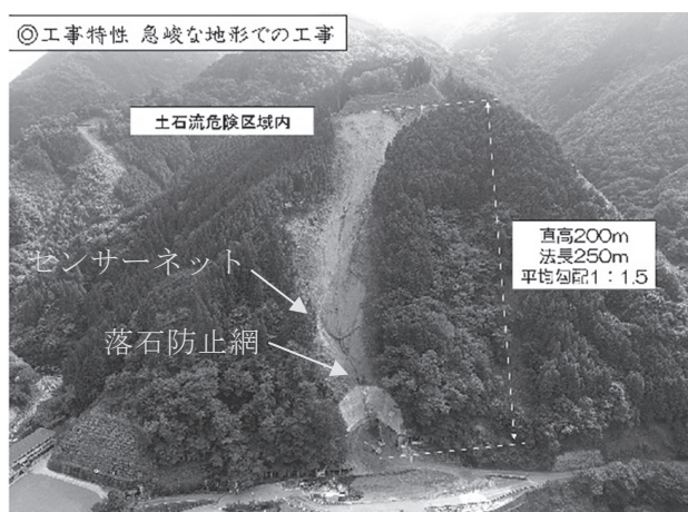
図-1 工事現場全景
