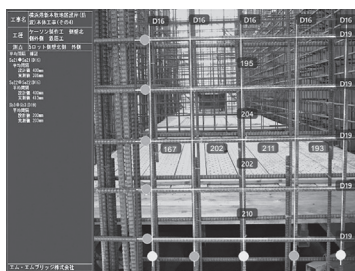
図-4 配筋検査結果（複鉄筋断面）
