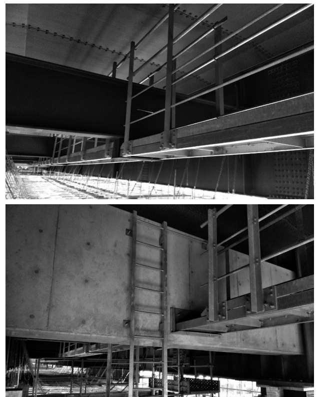
図-9 現地の設置状況
