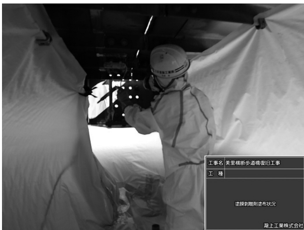
図-6 塗膜のはく離剤塗布状況
