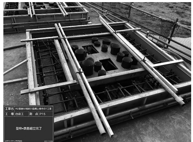
図-5 台座コンクリート型枠
