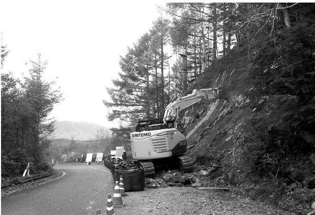
図-3 35号カーブ工区 吹付面 重機取り壊し
