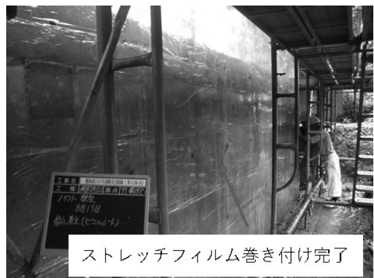
図-8 ストレッチフィルム巻き付け完了
