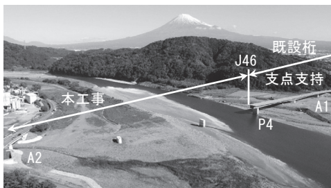
図-1 支点支持状態の既設桁（工事着手前）
