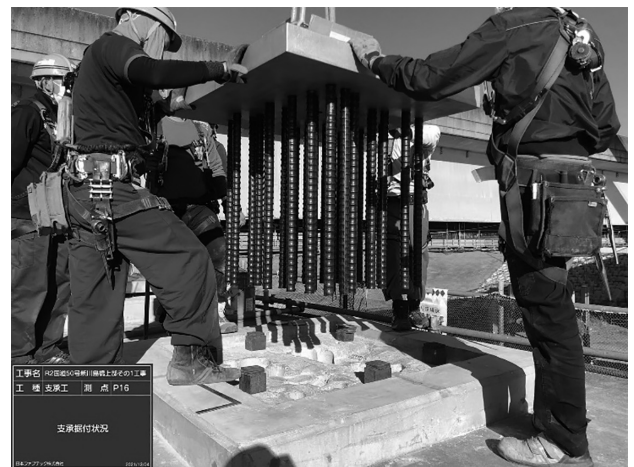
図-4 支承アンカーボルト (D41-30本)
