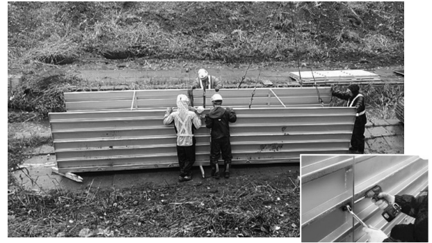
図-8 組立式水路組立状況
