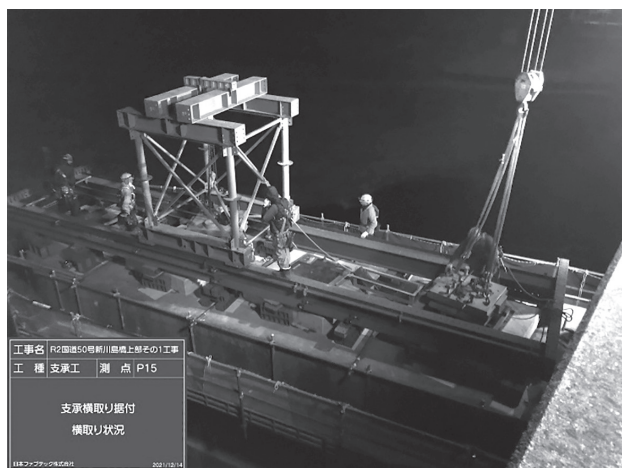
図-6 支承横取り状況
