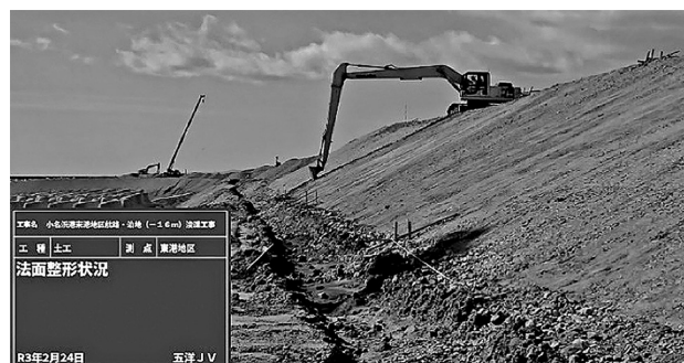
図-5 ロングブームバックホウによる法面整形作業状況
