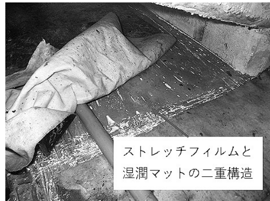
図-2 天端部の2重シート養生
