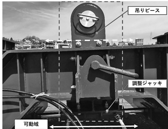
図9 吊りピースと連結した調整ジャッキ
