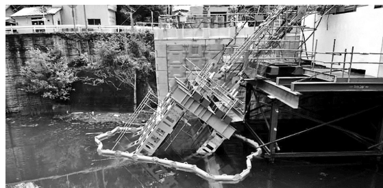
図-5 出水期におけるタワーベント
