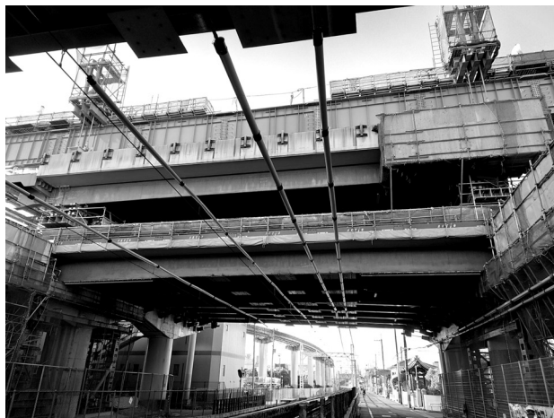
図-4 防護足場・下り線手摺防護
