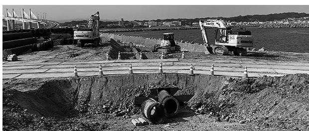
図-2 仮設道路設置時状況
