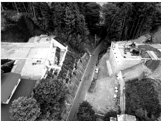
図-1 施工前状況(相川2号橋)
