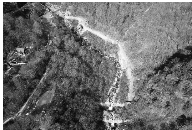
図-10 上流工事用道路全景
