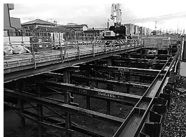
図-6 土留工全景
