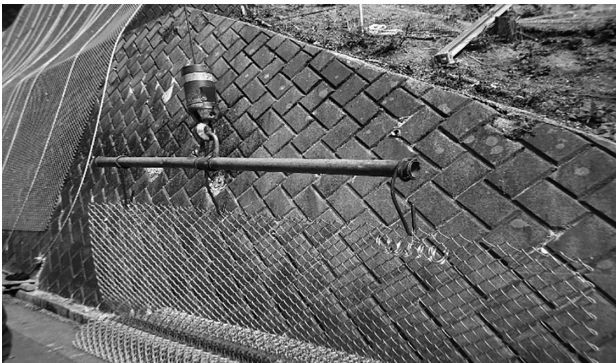
図-3 金網吊具作成
