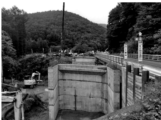
図-1 工事施工開始前状況
