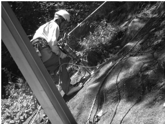
図-8 既設吹付面 コア抜き調査
