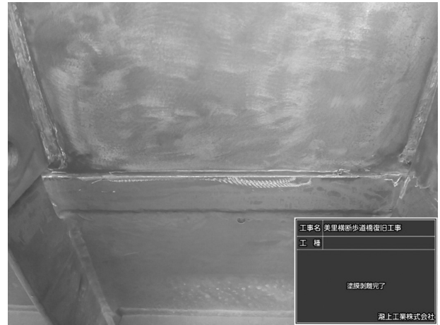
図-7 塗膜のはく離完了状態
