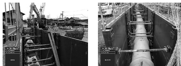
図-4 台付管の据付
