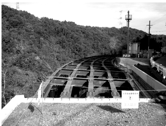
図-1 現場施工前状況
