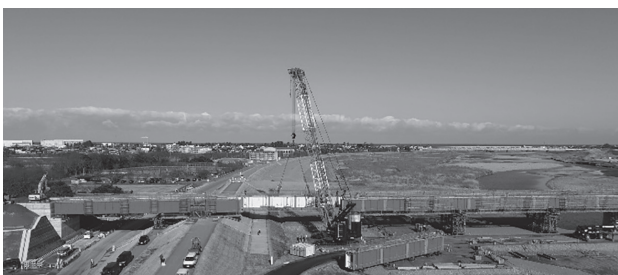
図-7 落とし込み架設状況
