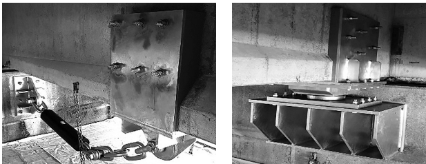
図-3 落橋防止システム設置完了写真
