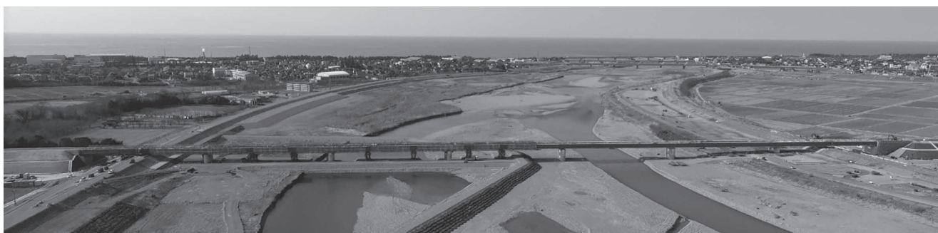
図-12 架設完了状況
