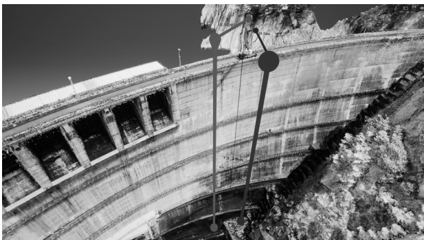
図-12 高さ、水平位置（点群）
