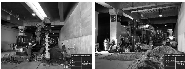
図-3 鋼矢板圧入施工状況
