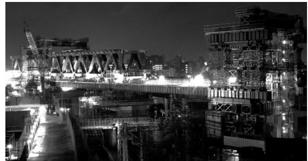
図-8 夜間トラス縦送り状況
