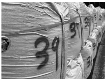
図-3 仮設大型土のう夜間視認性向上対策
