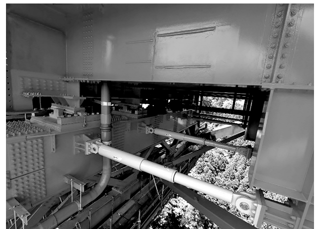
図-7 横梁部施工完了
