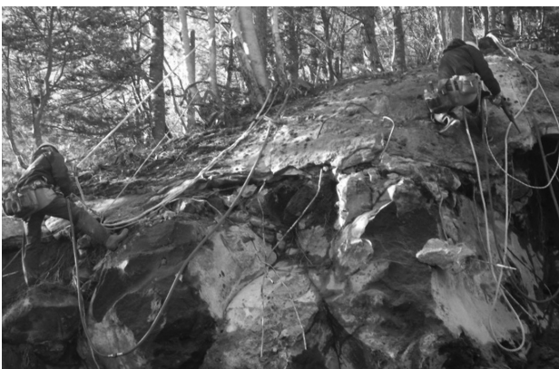
図-4 既設吹付法面 人力取り壊し
