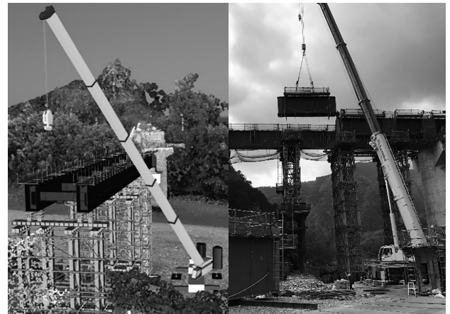
図-4 3次元モデルと実際の架設状況
