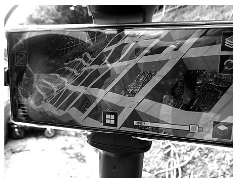
図-8 MR技術活用による芯出し作業
