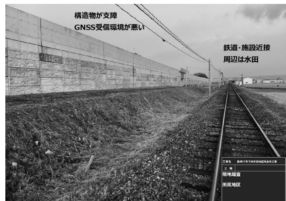
図-2 着工前状況
