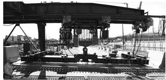
図-7 新設床版架設時の天秤構造
