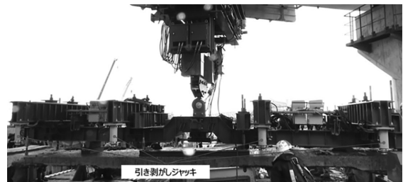
図-8 旧床版撤去時の天秤構造
