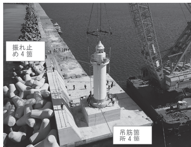
図-5 灯台設置状況
