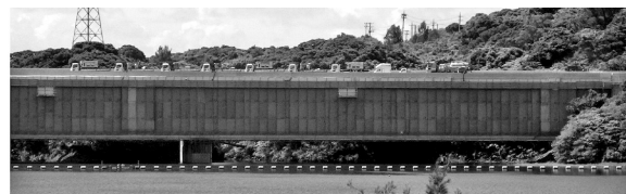
図-6 ブラスト施工状況
