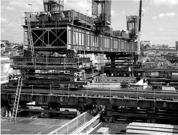
図-5 架設桁組立状況
