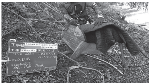
図-4 アンカー打込み作業時の騒音対策
