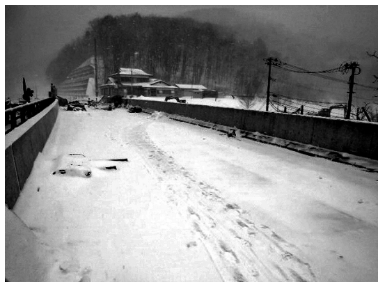
図-3 壁高欄完成
