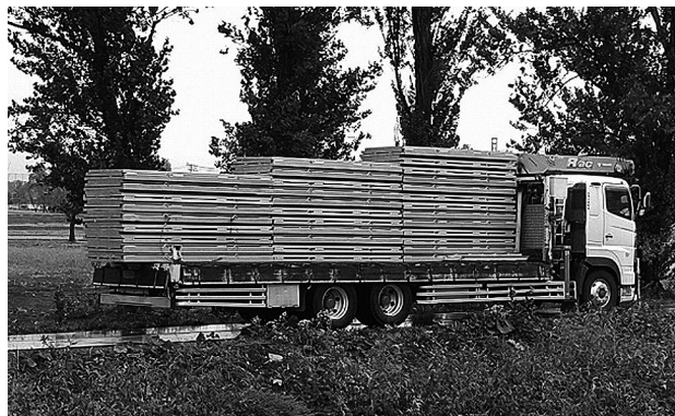
図-5 組立式水路運搬状況
