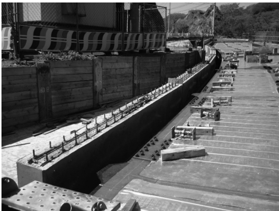
図-3 縦壁施工完了
