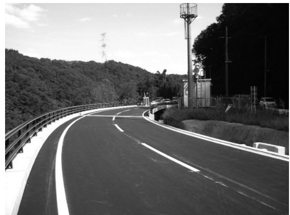
図-4 現場完成全景
