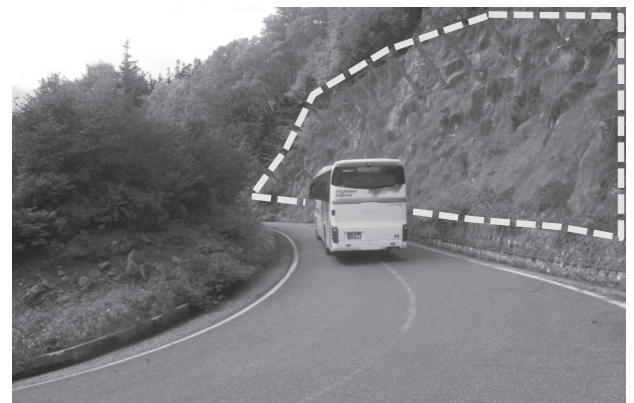
図-2 位ヶ原2号工区 バス走行 (点線内施工範囲)
