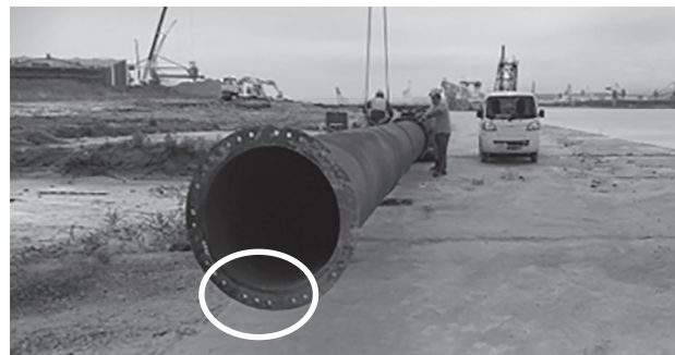
図-4 排砂管組立状況
