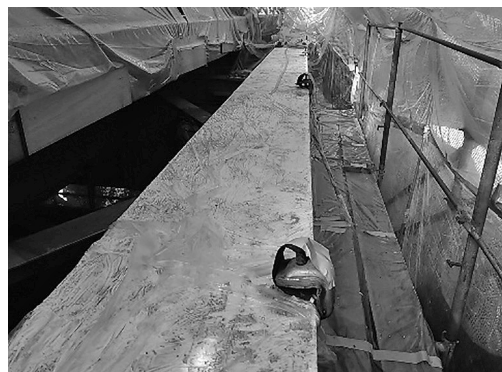
図-1 遮断層設置状況
