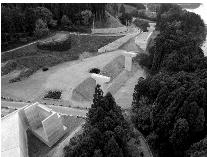
図-1 現場施工前
