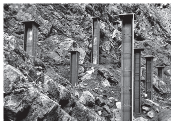
図-3 杭施工完了
