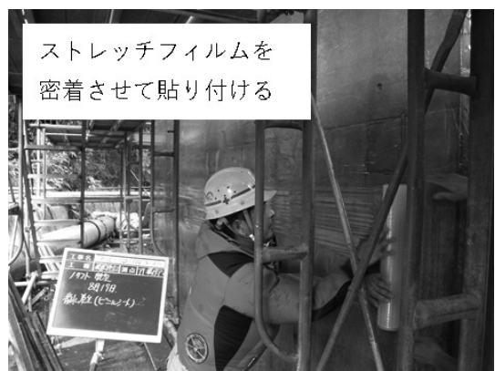
図-7 ストレッチフィルム巻付け状況
