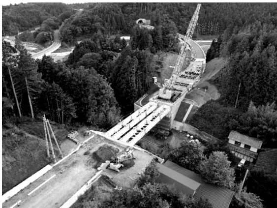
図-2 主桁架設作業完了
