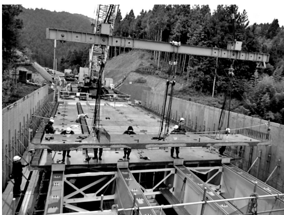
図-3 エルスジョイント施工状況
