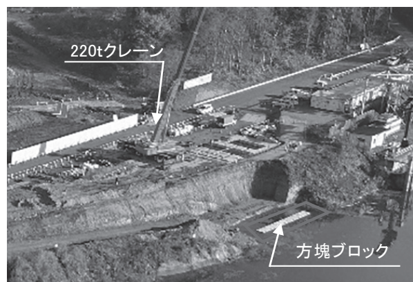
図-1 施工で使用した220tクレーン
