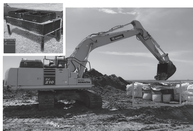
図-3 土のう作製枠使用状況
