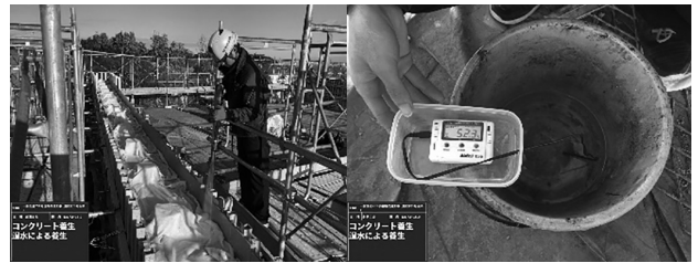
図-6 温水湿潤養生
