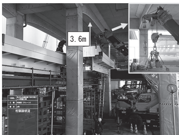
図-4 デッキ桁架設状況
