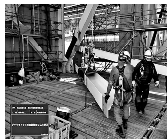
図-4 トラス部 部材吊り上げ状況
