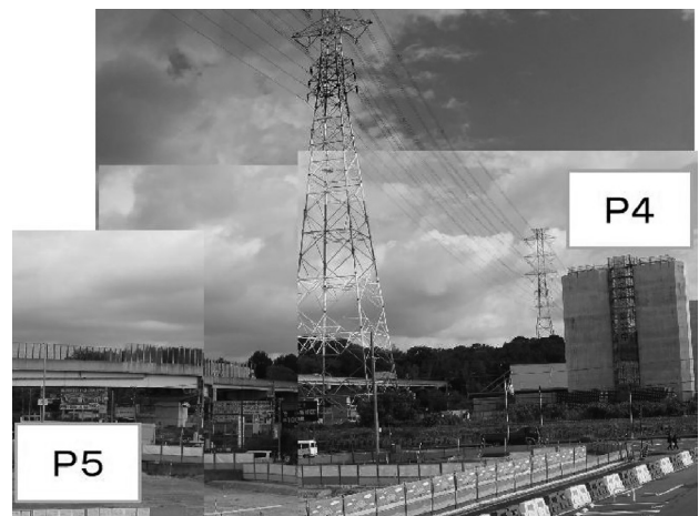
図-2 P4～P5間の現場状況 (施工前)
