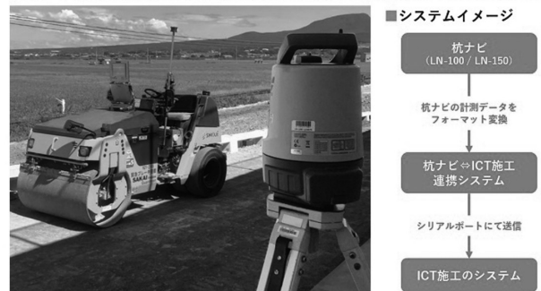
図-3 杭ナビ転圧管理システム
