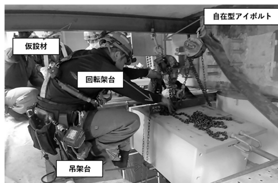
図-9 部材回転機構
