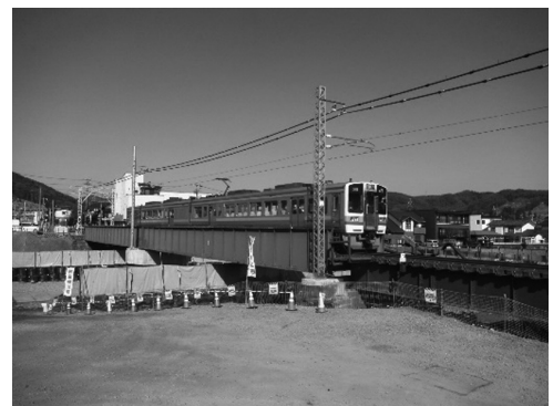
図-10 復旧後全景
