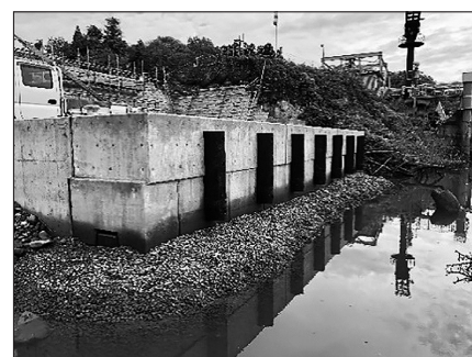
図-5 防舷材取付け完了時
