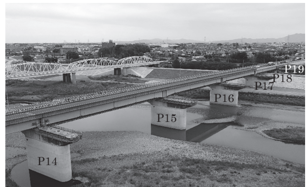
図-1 全景 (施工前)
