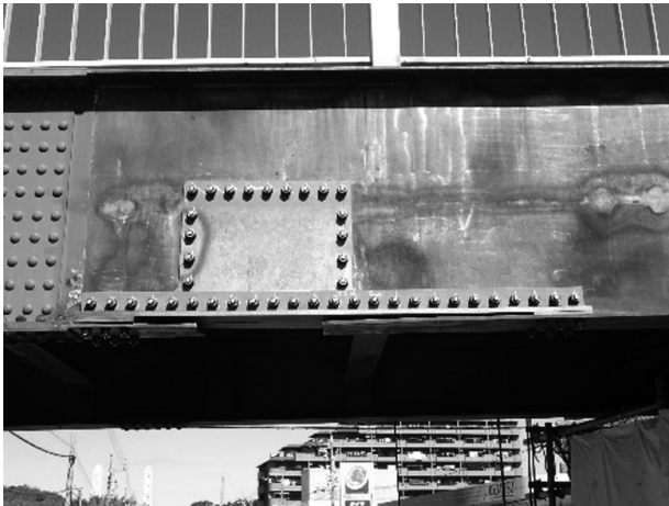
図-5 補強材取付け状況
