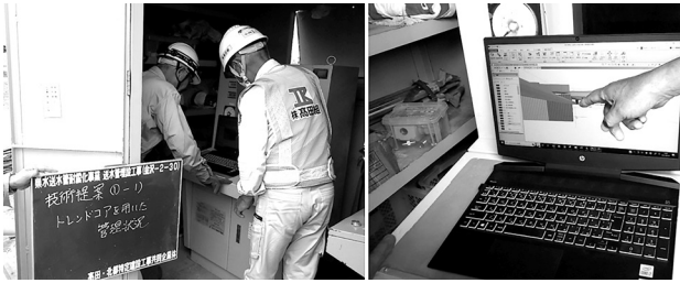
図-3 掘進機オペレーターとの土中地形確認
