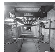
a) 補強状況
