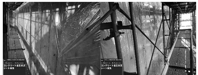
図-7 ビニールシート養生
