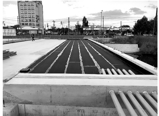
図-6 防水層の施工（1回目）
