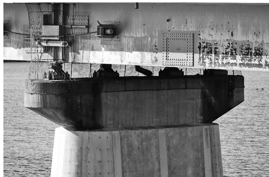
図-2 施工前状況
