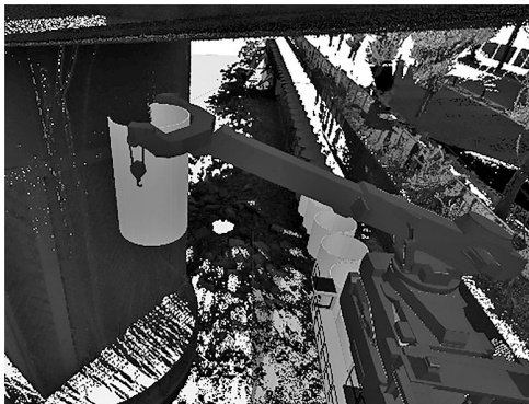
図-3 VRにおける橋脚との離隔距離確認状況
