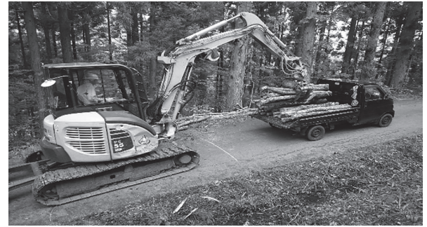
図-5 地元地権者引取り時の伐採木積み込み
