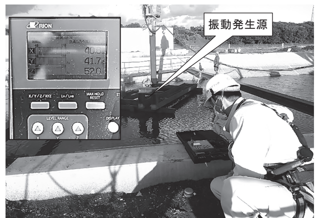
図-4 堤防振動測定状況の写真
