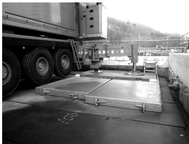
図-4 専用覆工板使用状況
