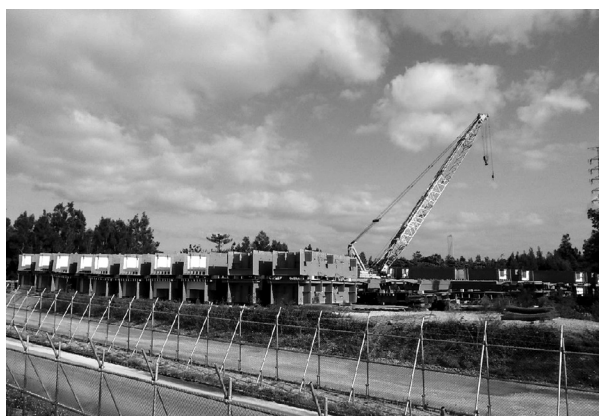
図-3 桁の仮置き
