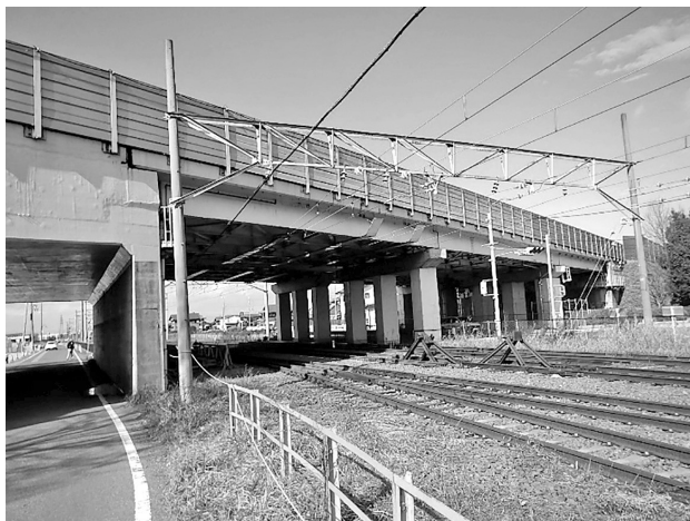
図-1 本線橋梁（多賀橋梁）
