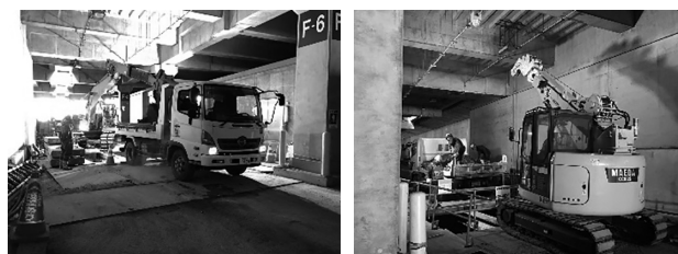
図-5 施工写真（掘削土砂積み込み）
