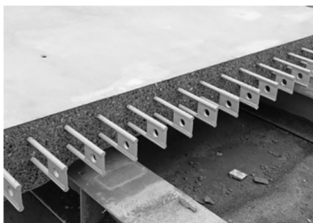
図-1 孔明き鋼板継手
