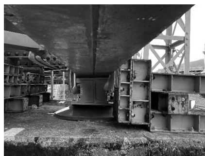
図-4 落橋防止設備設置状況
