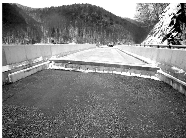
図-4 工事完成全景
