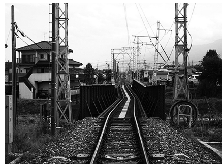
図-2 設備損傷状況
