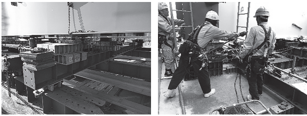
図-4 縦送り架台 図-5 縦送り状況
