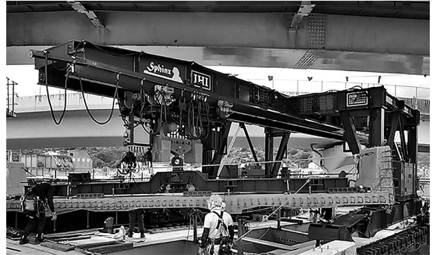
図-11 新設床版架設作業
