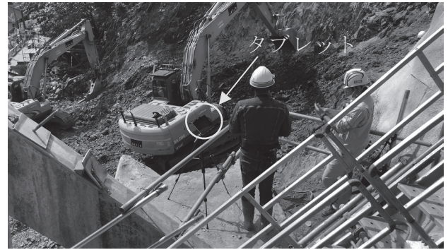
図-9 どこでもICT（左岸側）
