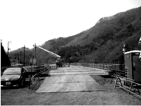
図-2 覆工板設置全景
