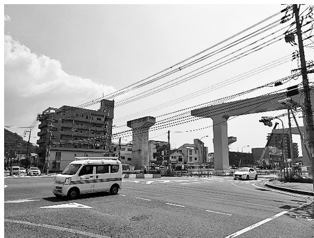
図-2 架空線状況
