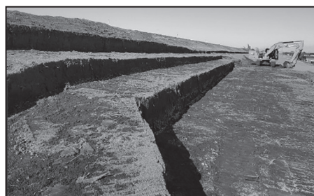
図-5 ICT重機による段切状況
