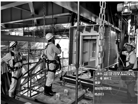
図-6 部材取込み状況
