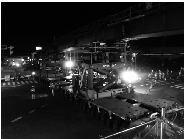
図-3 主桁架設時の状況
