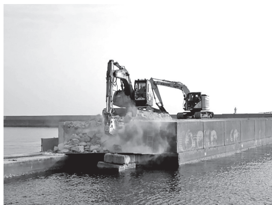
図-2 コンクリート取壊し状況
