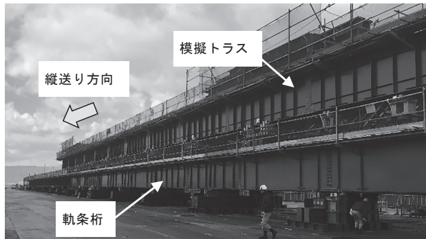
図-7 トラス縦送り実証実験
