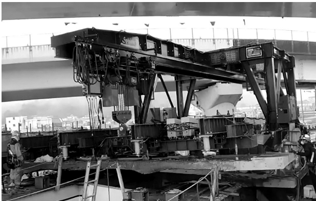
図-10 旧床版撤去作業
