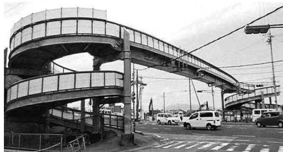
図-1 江戸橋横断歩道橋
