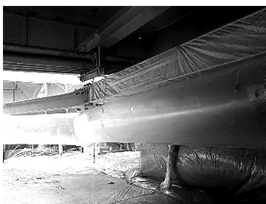
図-2 ジェットヒーター設置
