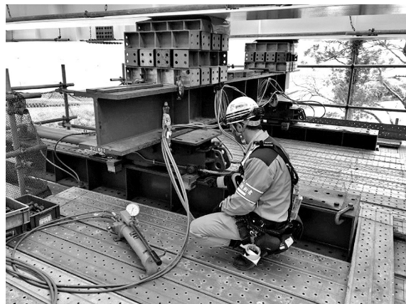
図-3 送りジャッキ装置
