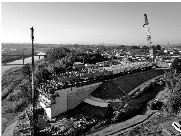
図-2 主桁地組立
