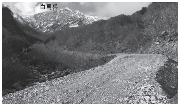
図-11 工事用道路（下流より上流を望む）
