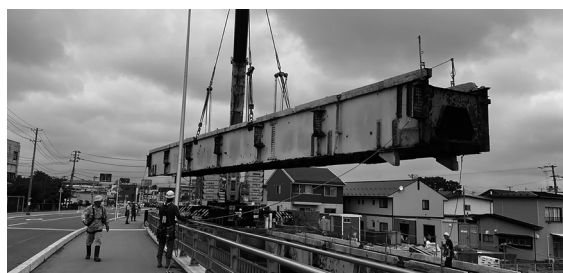
図-5 鋳桁部撤去要領図
