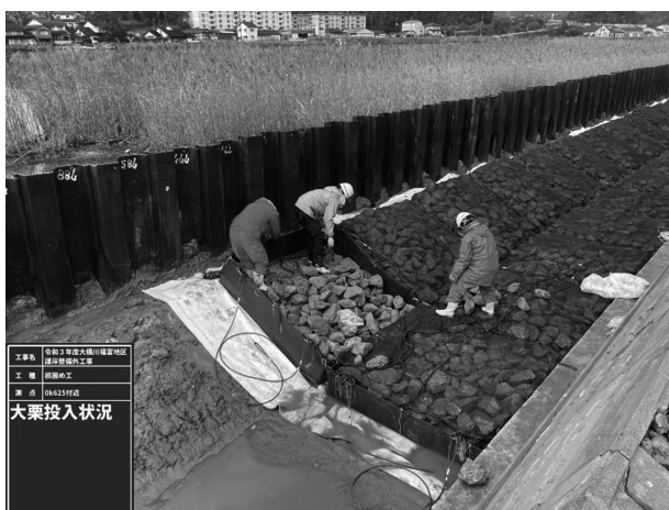
図-2 袋詰玉石製作状況：中詰材間詰
