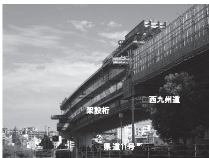
図-1 横取り架設完了状況
