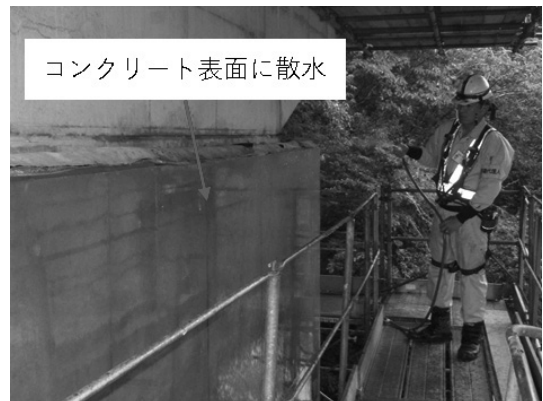
図-6 脱型後の散水状況
