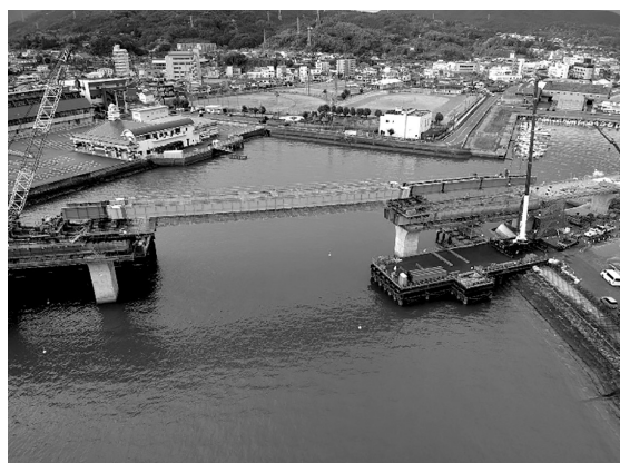
図-9 送出し架設完了時（全景）
