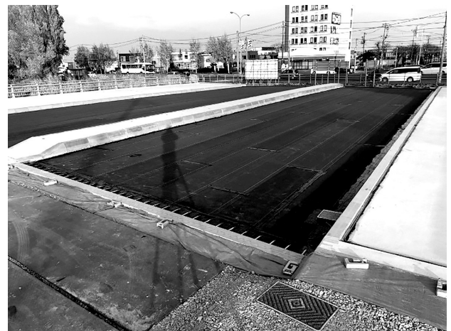
図-7 防水層の施工（2回目）
