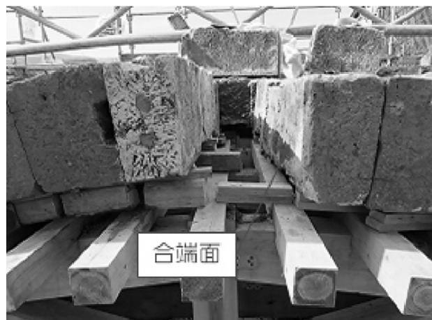
図-3 輪石組み1回目（下流側）
