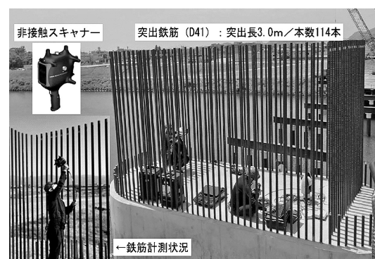
図-2 突出鉄筋と計測状況写真
