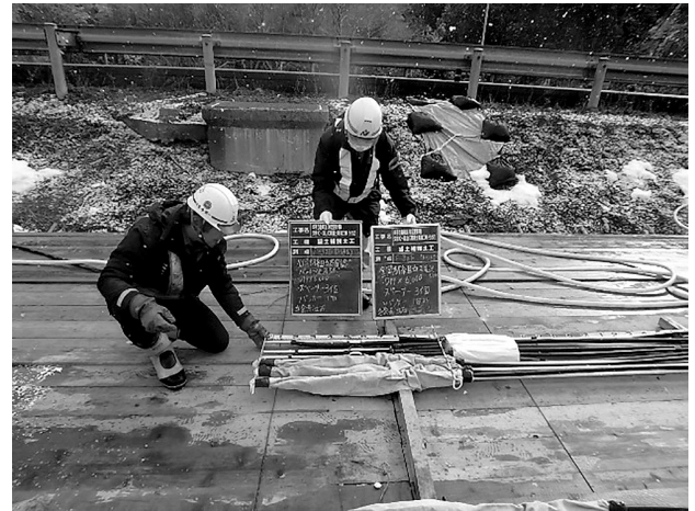
図-3 布製材料ロックボルトパッカー
