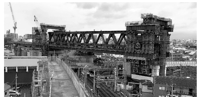
図-9 トラス縦送り完了
