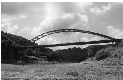
図-1 中津川橋全景（補修前）
