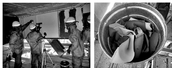
図-5 塗膜除去状況と剥離塗膜回収
