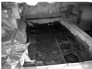
図-3 アンカー削孔状況
