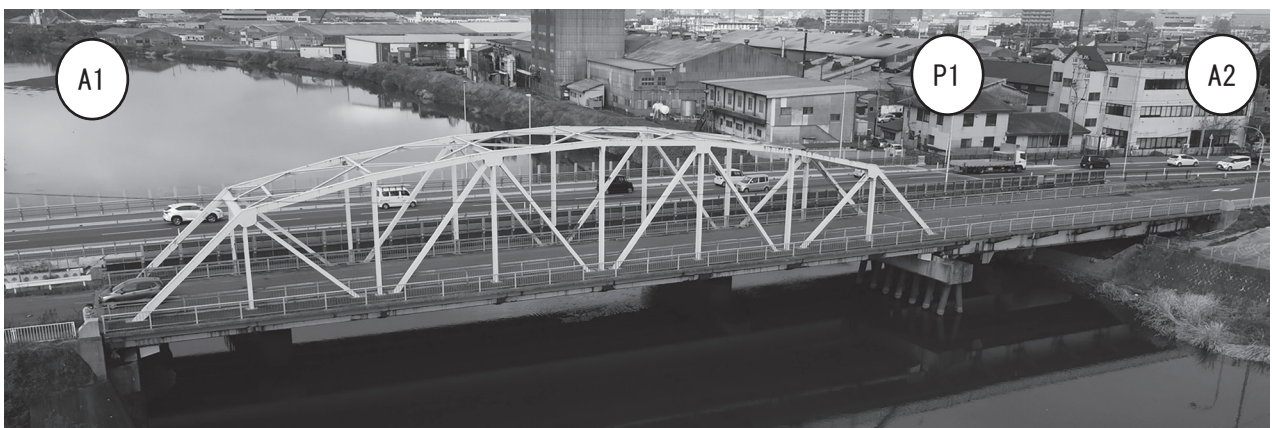
図-2 旧新川橋撤去前
