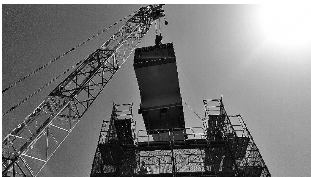
図-5 実際の架設状況
