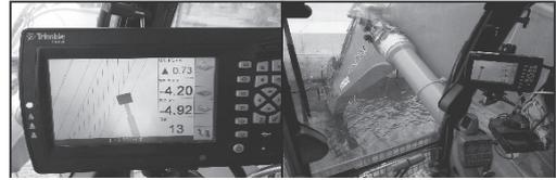
図7 GNSSによる施工状況
